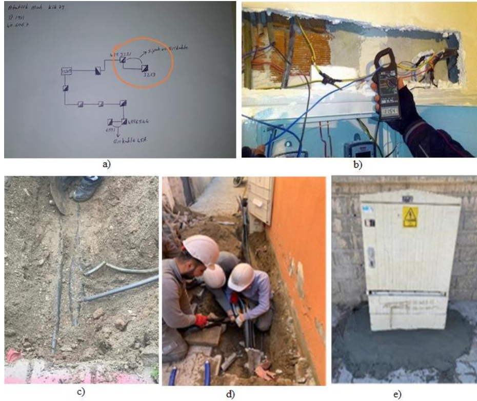
Şekil 3. Yer altı elektrik kablolarında kayıp tespiti ve onarım örnekleri
