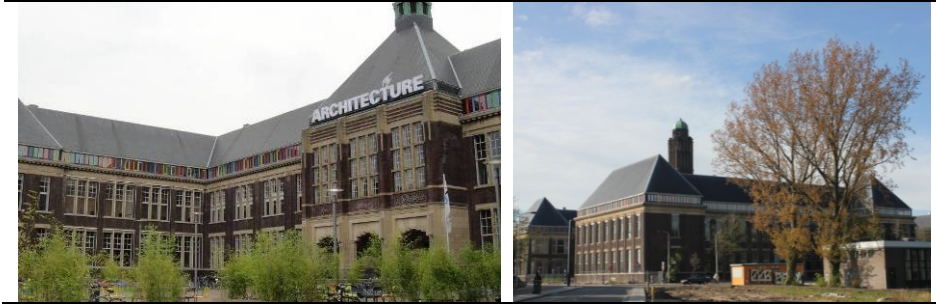
Şekil 3. Delft Teknik Üniversitesi Mimarlık Fakültesinin tarihi binası (Al, 2012)
