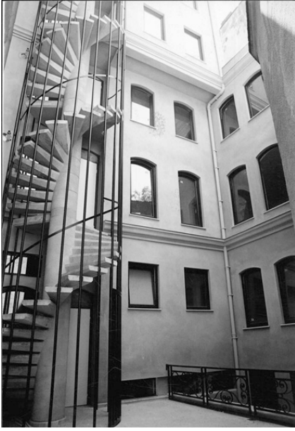
Şekil 8. Kanaat Kitabevi arka cephe.
