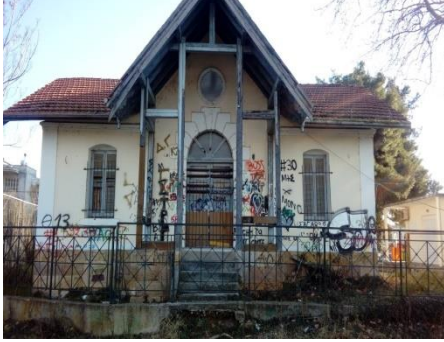
Fotoğraf 47: Askeri İstasyon ana cephe
