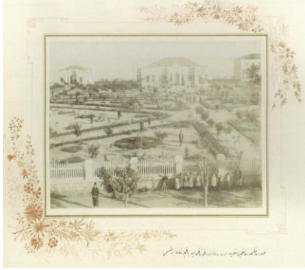
Fotoğraf 173: Dedeğaç hükümet konağı ve solda Camii
