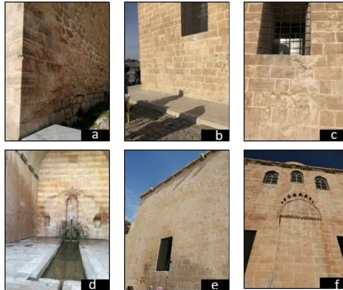
Figure 6. Chemical deterioration in Kasımiye Madrasah (Biçen Çelik, 2019)
