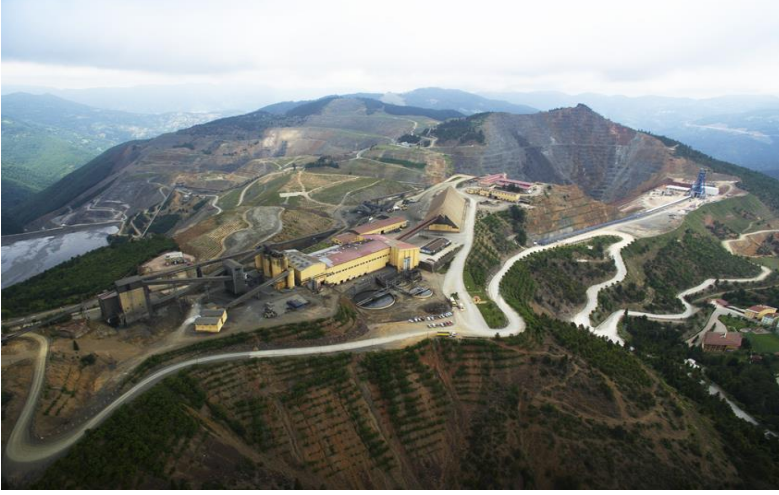
Ek-1) Eti Küre Bakır Maden İşletmesi
