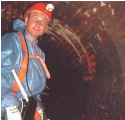
Şekil 2. Kanallarda yapılan incelemeye örnekler (tonoz yapılar)
