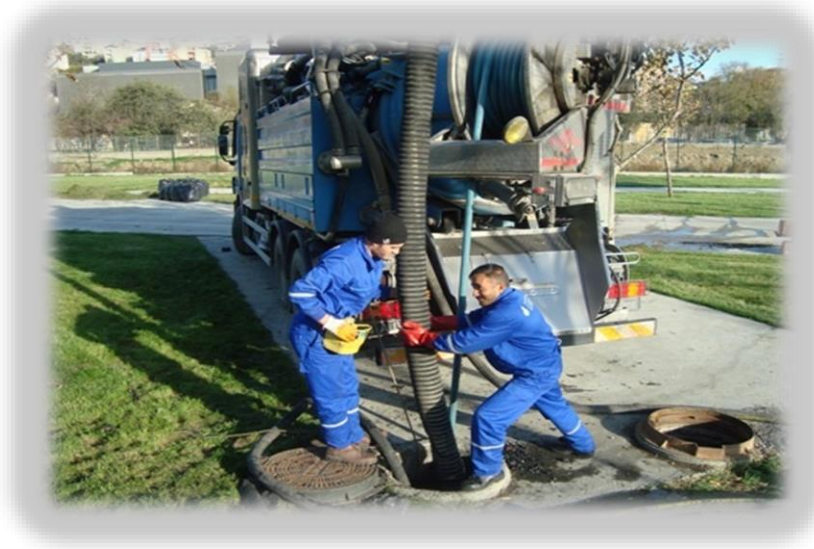
Şekil 1. Kombine ile kanal temizliği
