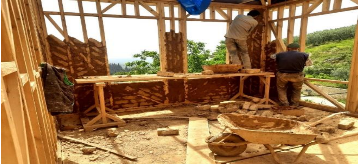
Şekil 8. Kerpiç örülmesi
