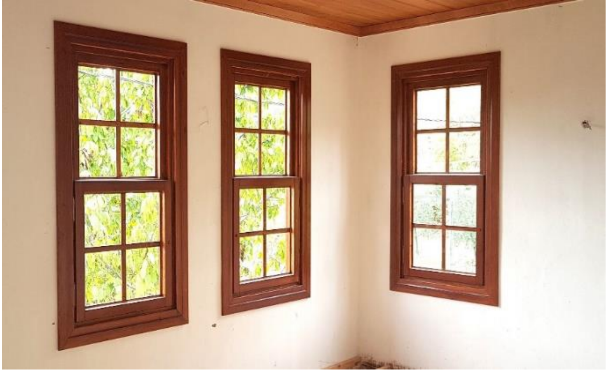
Şekil 13. Pencereilerin montajı, bire iki oranı ve giyotin görünümlü kanatlı
