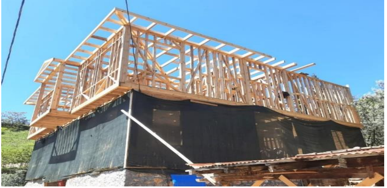
Şekil 7. Taş duvar, ahşap karkas
