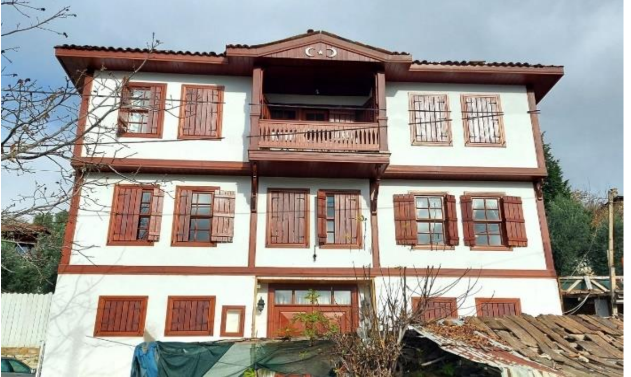
Şekil 18. Akın Evi'nin bitmiş hali ön cepheden görünüşü
