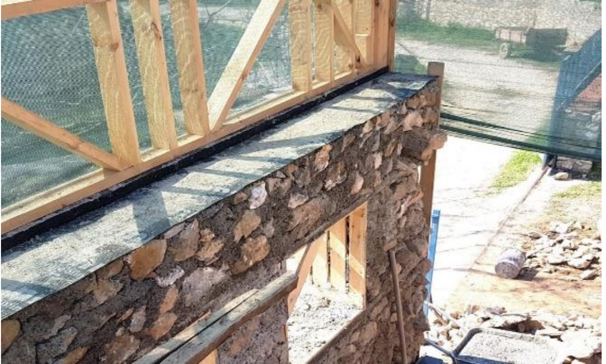
Şekil 6. Taş duvar ile ahşap duvar arasındaki ilişki
