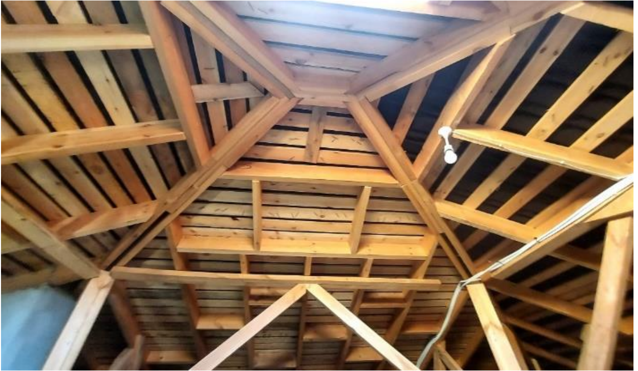
Şekil 10. İç taraftan çatı konstrüksiyonu
