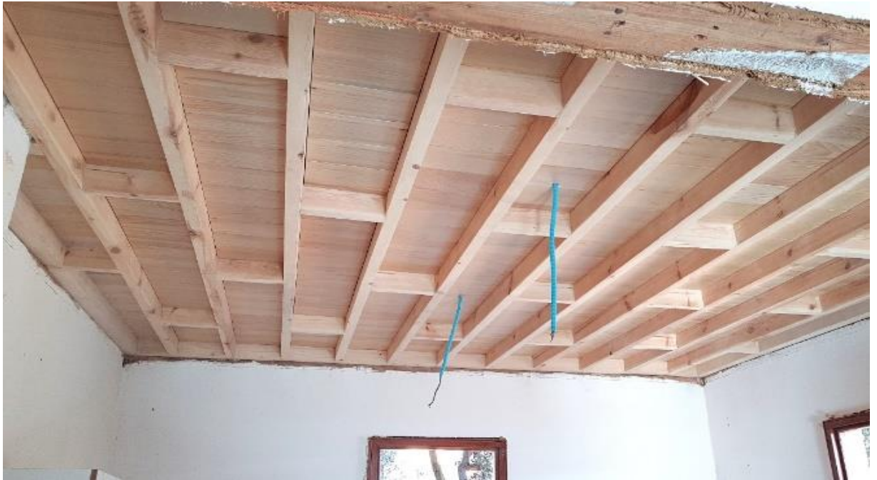
Şekil 16. Mutfak üzeri bakkal tavan uygulaması
