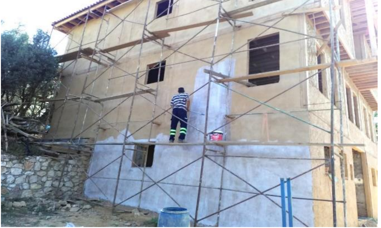
Şekil 15. Kireç badananın sürülme işlemi
