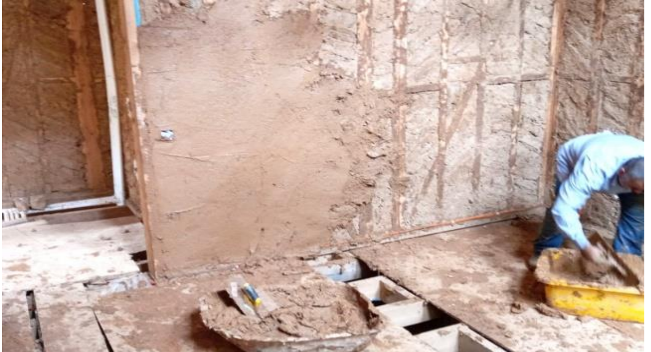
Şekil 12. Ahşap duvar üzeri kerpiç sıvanın kaba aşaması
