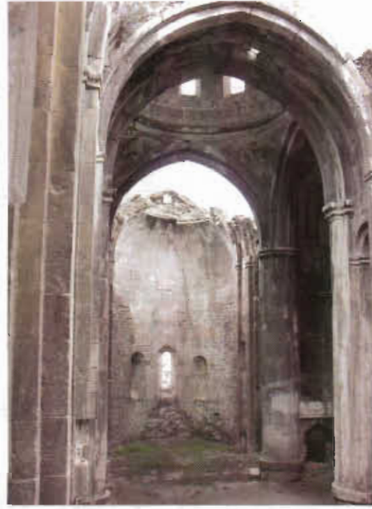
Şekil 5. Onarım ve koruma tedbirleri uygulanmadığından kilisenin çatı sistemi sürekli olarak tahrip olmaktadır.
