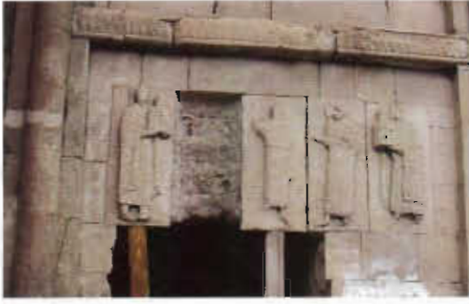
Şekil 4. Kilise duvarlarından sökülen taşlar nedeni ile çeşitli kahartmalar tahrip olmakta ve geçici tedbirlerle kısmen korunmaya çalışılmaktadır.
