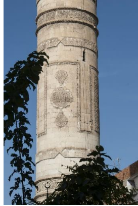
Görsel 8. Diyarbakır Parlı Safa Camii minaresindeki şemse.
