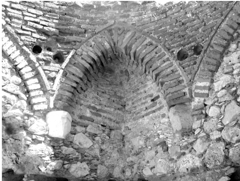
Res. 2- II No.lu Türbe'nin tromplarından biri.
