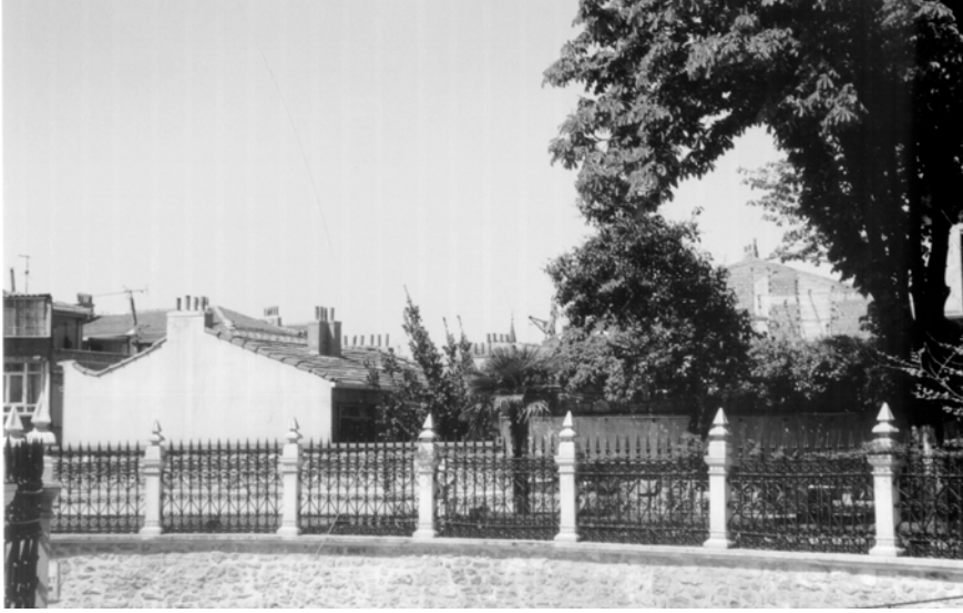
Res. 9- Fatih Hırka-i Şerif Camii, çevre duvarı.
