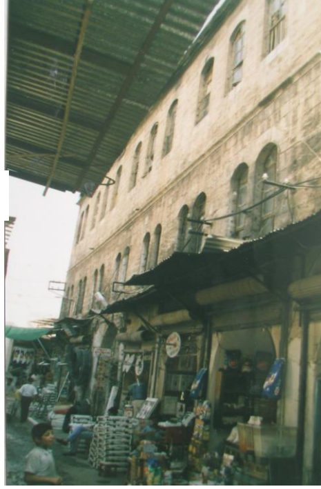
Res.5- Barutçu Hanı, kuzey cephe.
