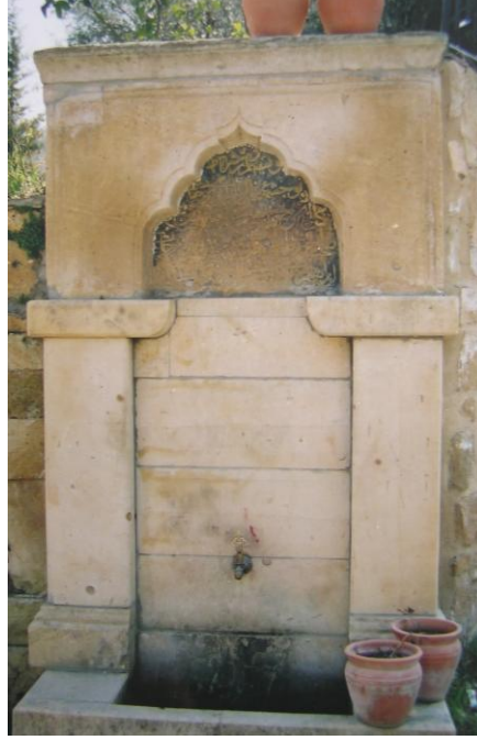
Res.21- Hazire avlusunun köşesindeki çeşme.
