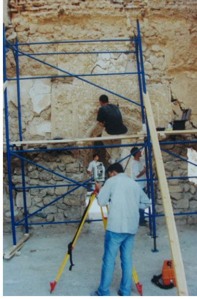
Res.13- Ko Camisi, Eyvan Sslemeleri zerinde Yapılan Geici Koruma Calışmaları
