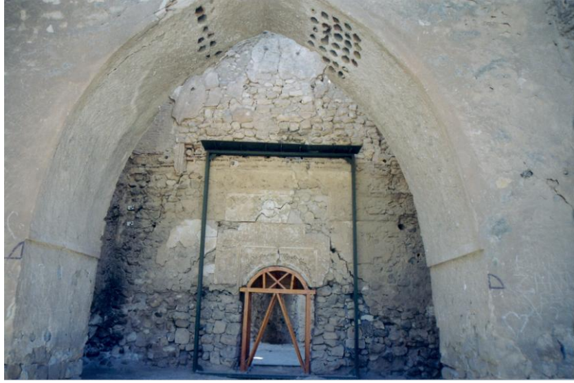
Res.16- Ko Cami Eyvan Duvarında Yapılan Geici Destek (Foto M. eken)
