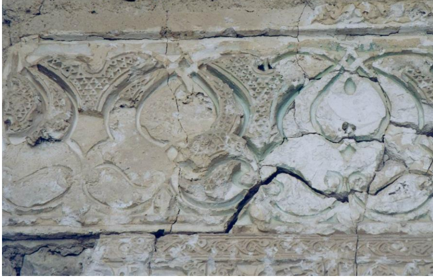
Res.9- Ko Cami Eyvan Duvarındaki Sslemelerden Detay
