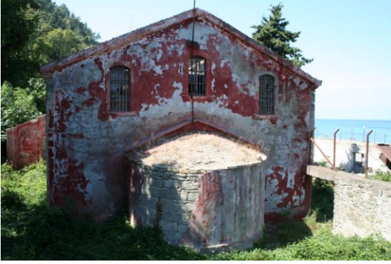
Res.8- Doğu cephe.
