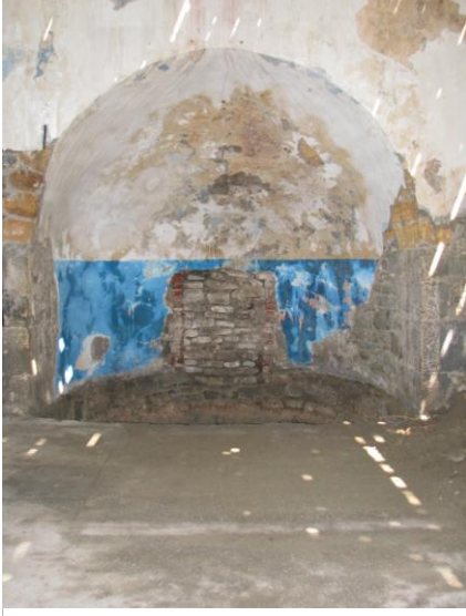
Res.6- Sıva raspası yapıldıktan sonra apsis içinde ortaya çıkan pencere.
