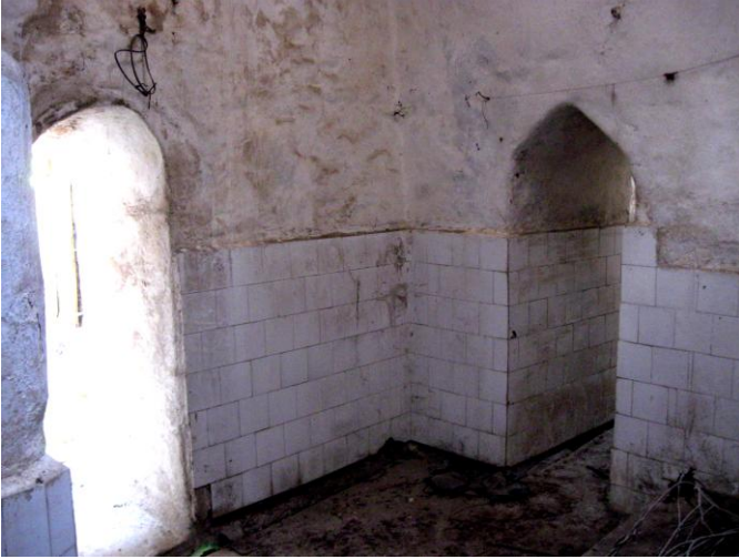
Res.10- Iılıklik mekanı, sağda sıcaklık kapısı
