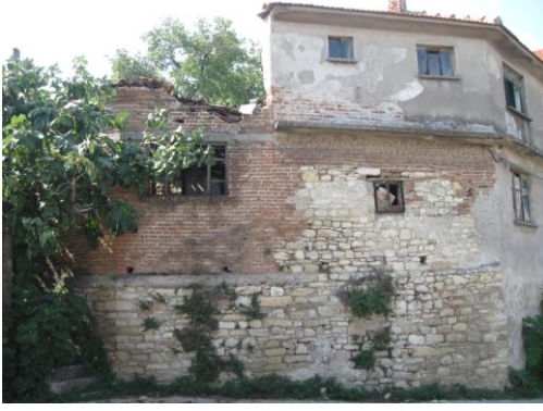
Res.7- Metruk hamamın soyunmalık cephesi
