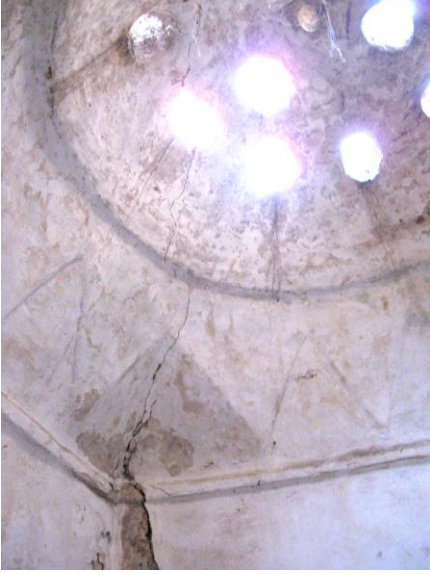
Res.9- Iılıklik mekanında geçiş ve örtü sistemi
