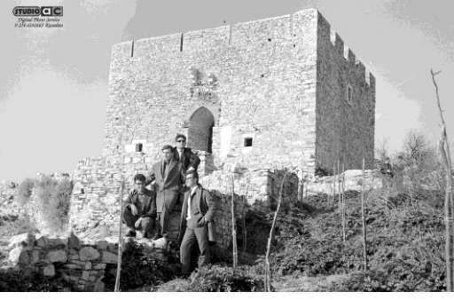
Resim 4: Kuleye girişi sağlayan kapı, güney cephe (Studio AC Arşivi'nden).
