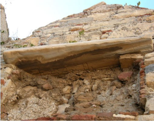
Resim 13: Girişin üzerindeki devşirme blok.
