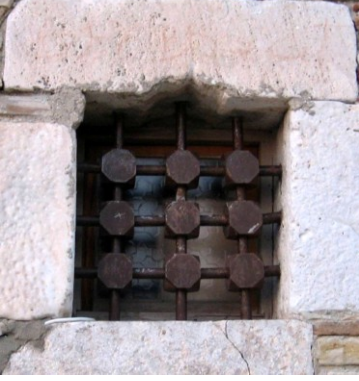
Resim 6: Kaş kemer formu verilmiş söve.
