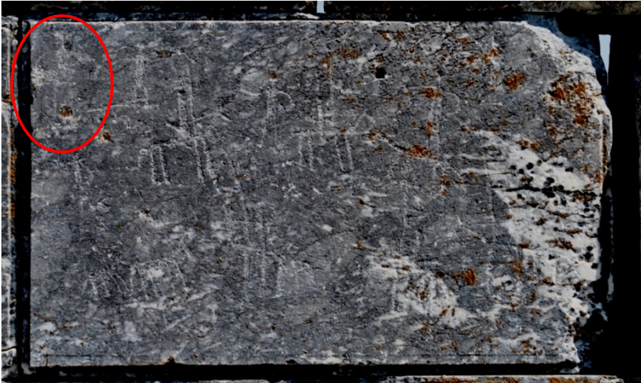
Fot. 13: Kuzey İç Cephede, Alttan Altıncı Sırada, Doğudan Batıya Doğru İkinci Blok
