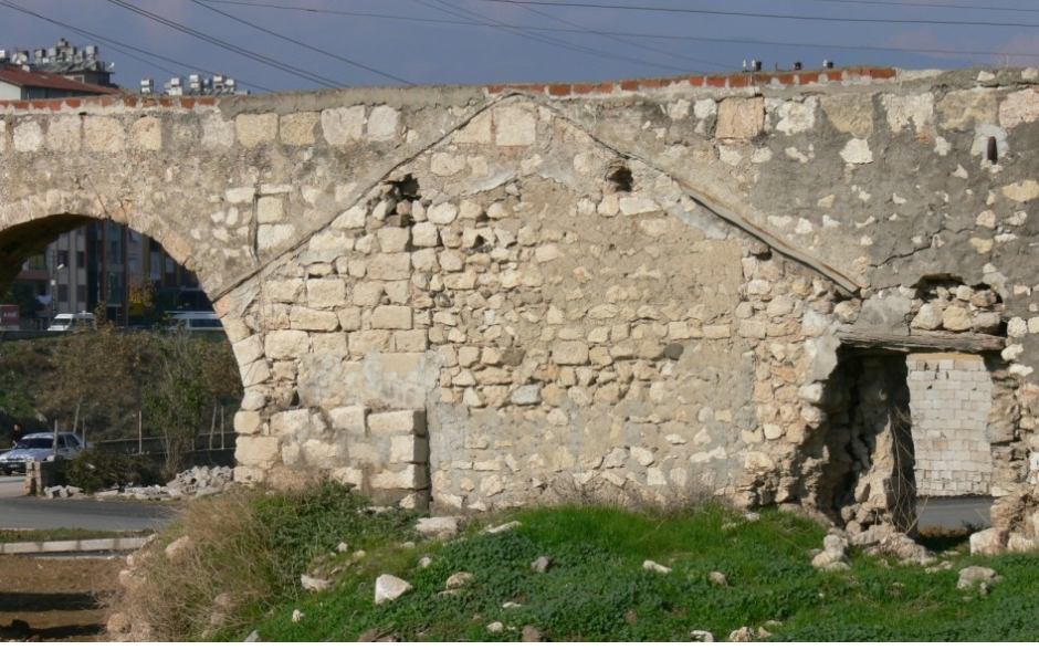
Res.14- ‘Alvân Su Kemerı; masıf bölümde tabakhane mekanlarının izleri. (Güneyden)
