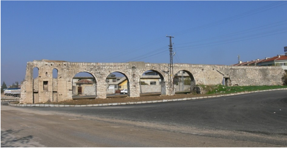
Res.13- ‘Alvân Su Kemerî; güneyden genel görünüş.
