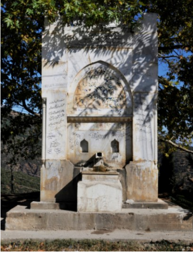
Res.2- Paşa cephesi, ön cephe.
