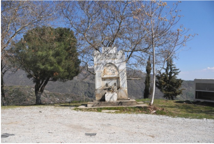
Res.1- Ödemiş-Bozdağ yolu Paşa Çeşmesi, genel görünüş.
