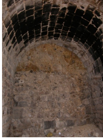
Fotoğraf 19: Yeşilburç Köyü Hamamı, külhan kısmı.
