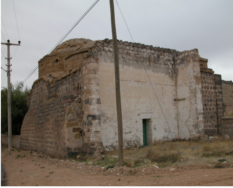
Fotoğraf 3: Hamamlı Köyü Hamamı, güneybatı taraftan görünüş.
