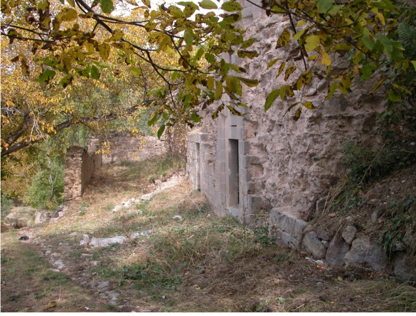
Fotoğraf 9: Yeşilburç Köyü Hamamı, güney taraftan görünüş.
