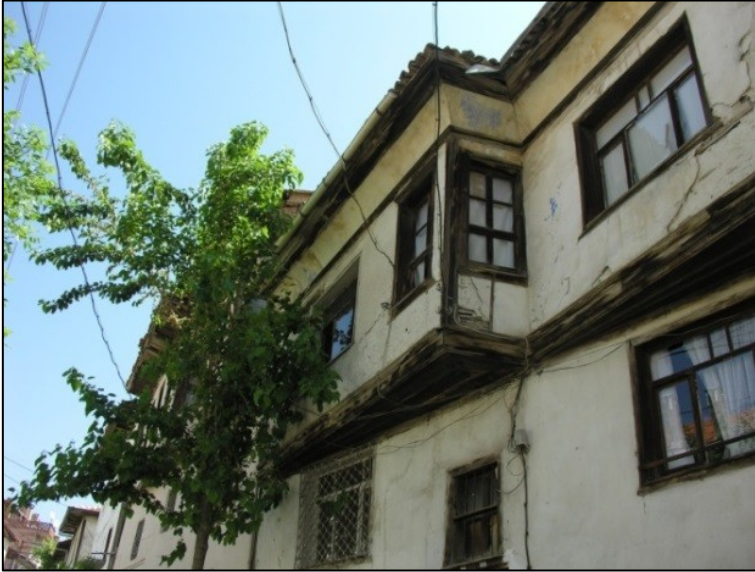
Fotoğraf 25 , Ahşap hatıllı çıkmanın alttan kapatıldığı uygulama.
