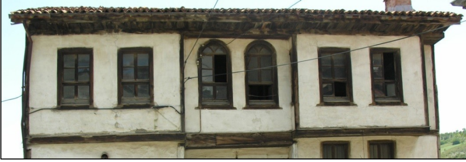
Fotoğraf 28, Dikdörtgen ve yuvarlak kemerli pencere örnekleri.
