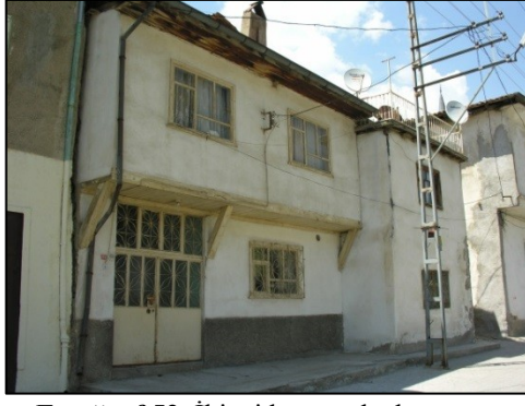
Fotoğraf 52, İkinci katı cephe boyunca düzgün çıkma oluşturan bir örnek.
