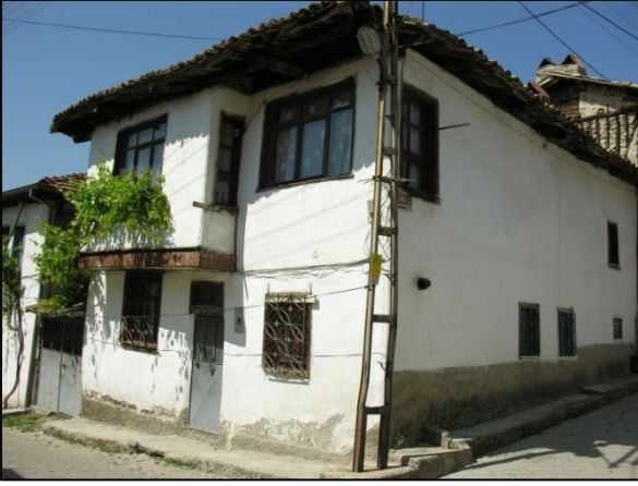
Fotoğraf 48, Hem giriş aralığını örten hem de cephenin yarısını kapsayan bir çıkma örneği.
