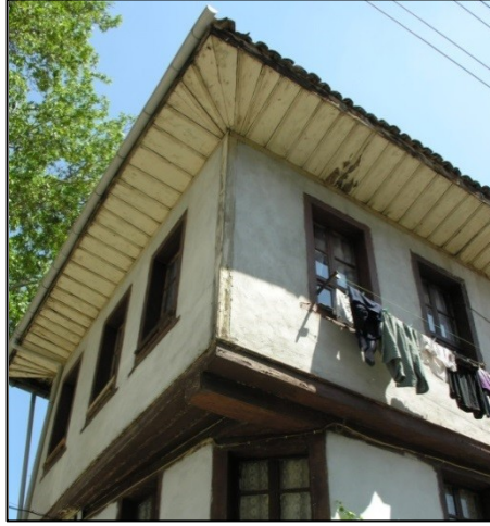
Fotoğraf 34, Kaplamasız saçak örneği. Fotoğraf 35, Dekoratif kaplamalı saçak örneği.
