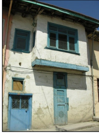
Fotoğraf 49, Cephenin ortasında yer alan oda çıkma örneği.
