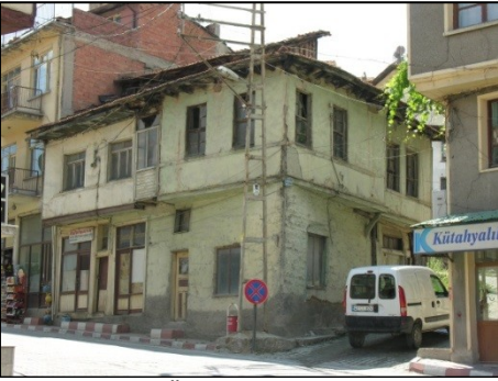
Fotoğraf 52, Ön cephesi bir, yan cephesi iki kademeli gönye çıkmalı bir örnek.
