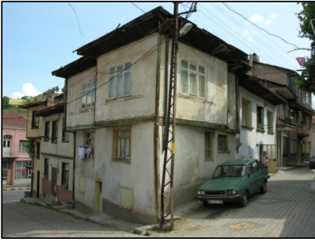
Fotoğraf 53, Her iki cephesi de iki kademeli gönye çıkma yapan bir örnek.
