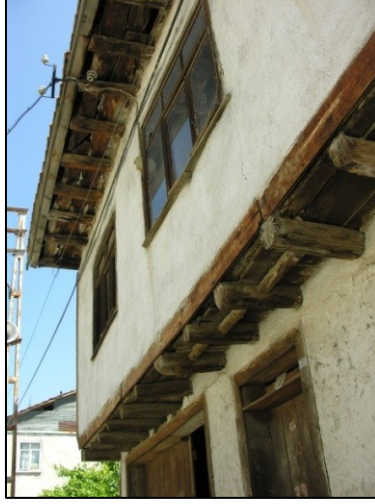
Fotoğraf 24 , Ahşap hatıllı çıkma.
