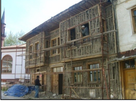
Fotoğraf 75, Tamamı bağdadi inşa tekniği. ile inşa edilmiş bir ev Eskişehir Beld. Arşv.
