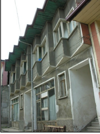
Fotoğraf 73 , Gönye çıkmalı örnek. Fotoğraf 74 , Modern balkonlu, çıkmasız bir örnek.
