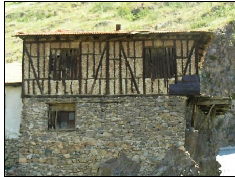
Fotoğraf 15 , Zemin katı taş, üst katı bağdadi teknikli ev örneği.
