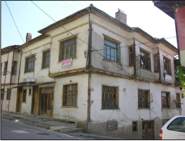
Fotoğraf 29, Üst ve iki yan kanat sabit, ortası hareketli kanatlı pencere tipi.
