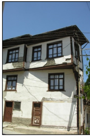
Fotoğraf 30, Üst, alt ve orta sabit, iki yan kanadı hareketli pencere tipi.
