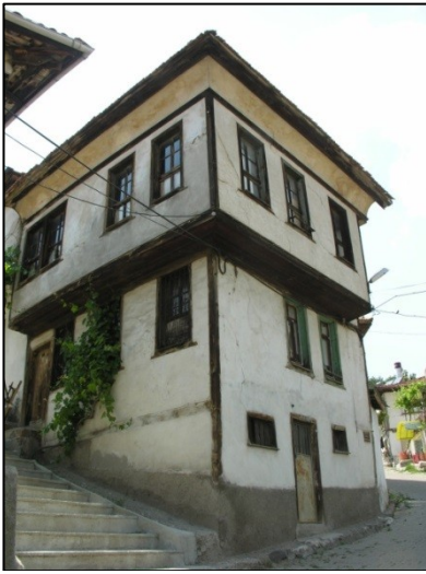
Fotoğraf 26, Eskigediz evinde ahşap hatıllı cephe uygulaması.
