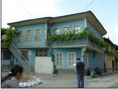
Fotoğraf 55, Ön cephesi iki, yan cephesi bir kademeli gönye çıkmalı bir örnek.
