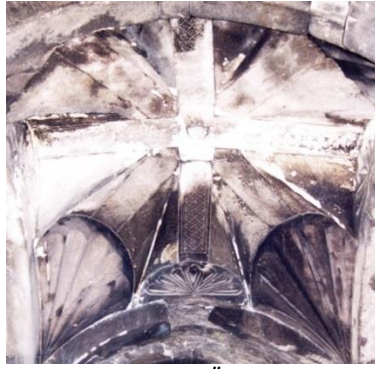
Fotoğraf 172, Çizim 49. Çamlıyamaç (Öşk) Manastırı Kilisesi, kristogram şeklinde haç tonoz örtü.
