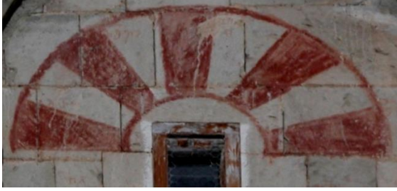
Fotoğraf 181. Altıparmak (Parhal) Manastırı Kilisesi, boyama tekniğinde sahte kemer düzenlemesi.
