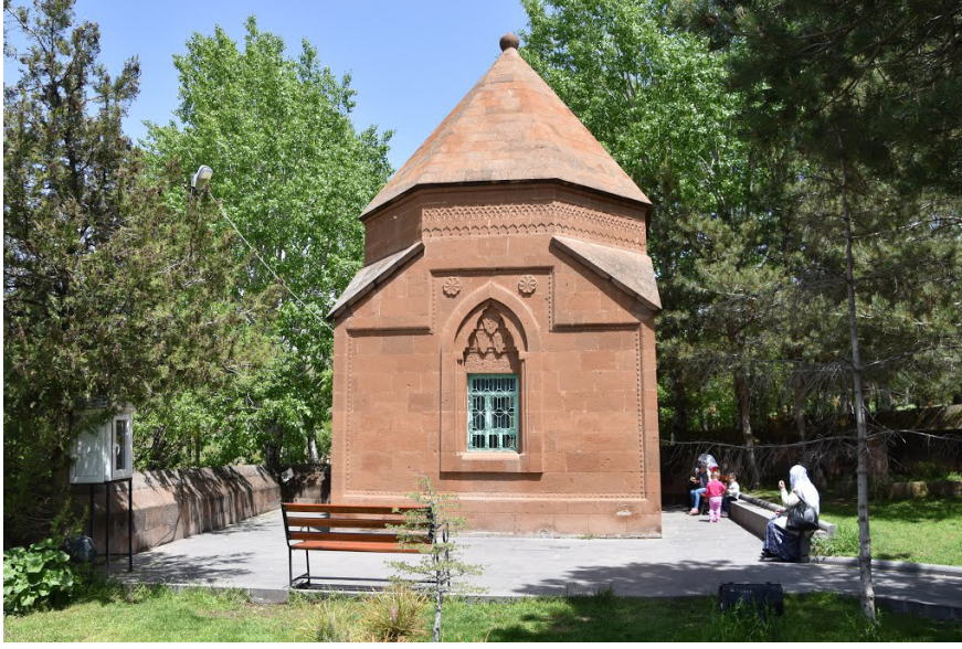
Resim 2: Türbenin bahçe içerisinde bir görüntüsü
