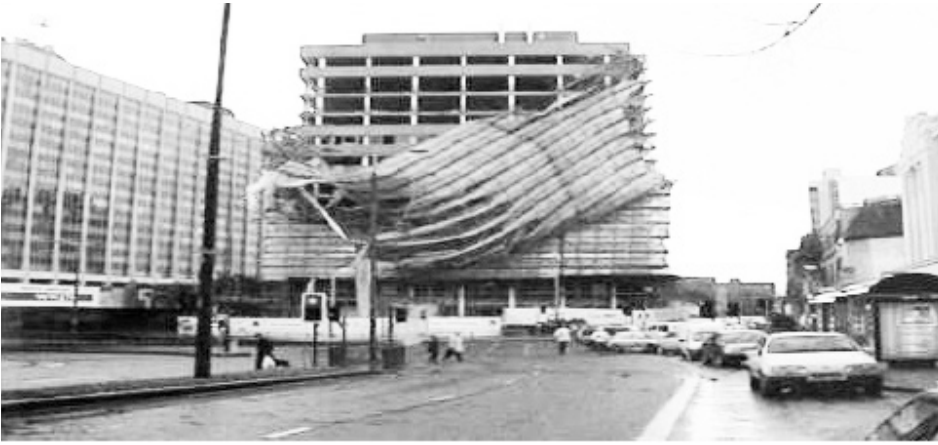
Resim 1: İskelede bağlantının kopması.
