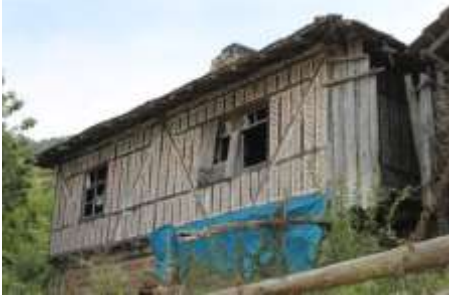
F.23.Şahinkaya Köyü 9 Nolu Ev
