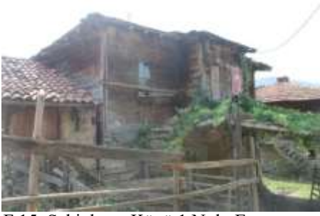
F.15. Şahinkaya Köyü 1 Nolu Ev
