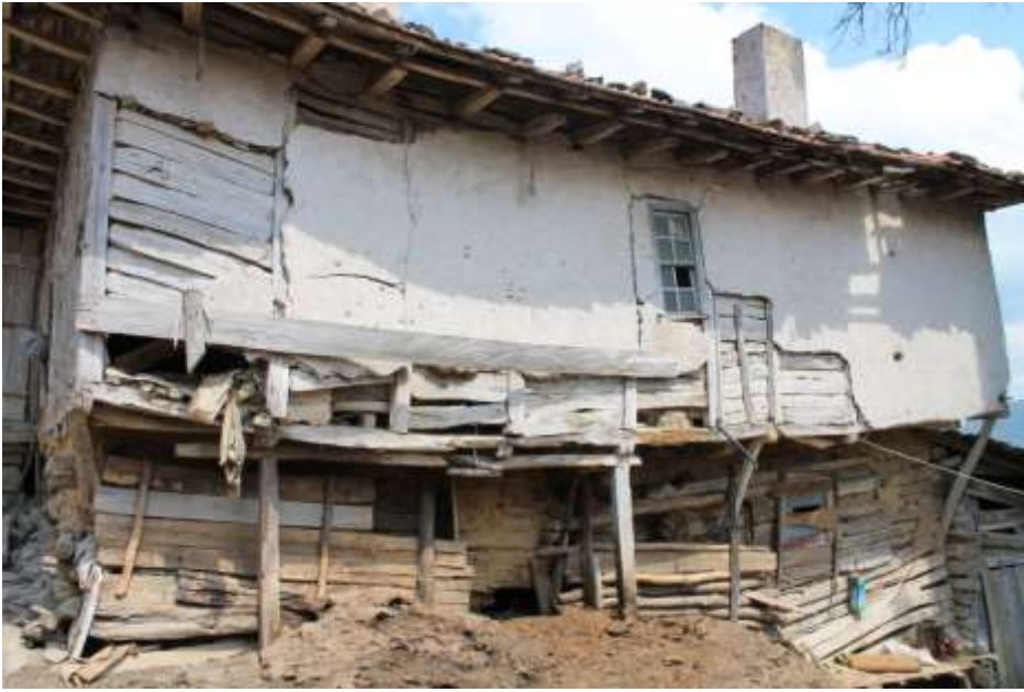
F. 35. Meşelitürkmenler Köyü 4 Nolu Ev
