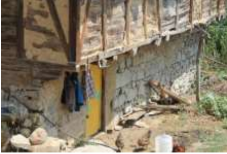
F.33.Meşelitürkmenler Köyü 2 Nolu Ev
