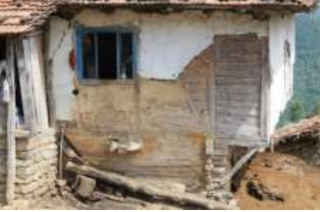
F.34. Meşelitürkmenler Köyü 3 Nolu Ev
