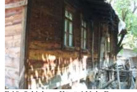
F.18. Şahinkaya Köyü 4 Nolu Ev
