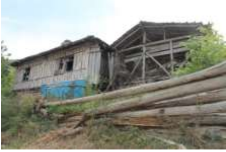
F.19. Şahinkaya Köyü 5 Nolu Ev
