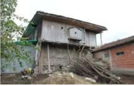
F.9. Terzili Köyü 5 Nolu Ev
