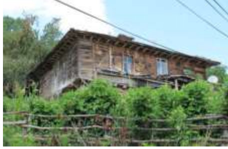
F.32. Meşelitürkmenler Köyü 1 Nolu Ev
