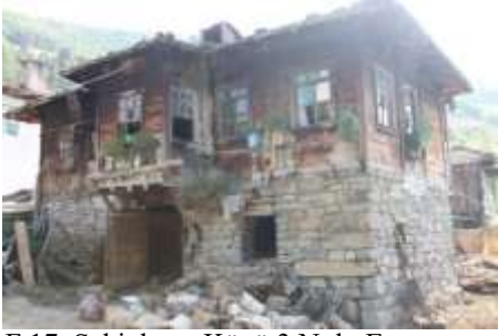
F.17. Şahinkaya Köyü 3 Nolu Ev
