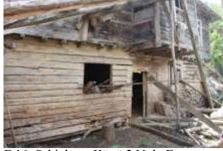
F.16. Şahinkaya Köyü 2 Nolu Ev
