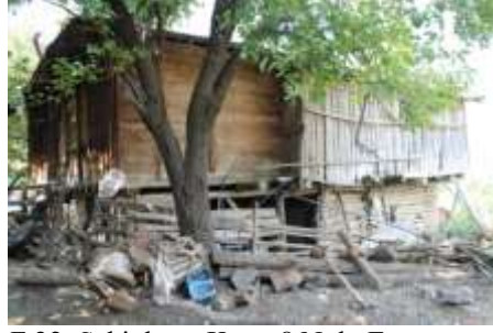
F.22. Şahinkaya Köyü 8 Nolu Ev
