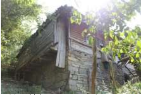
F.21. Şahinkaya Köyü 7 Nolu Ev
