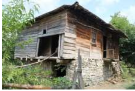
F.20. Şahinkaya Köyü 6 Nolu Ev
