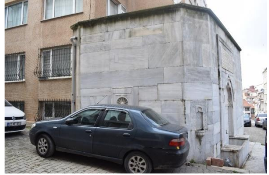
Fotoğraf 27: Kaptan Paşa Çeşmesi Güney Cephe
