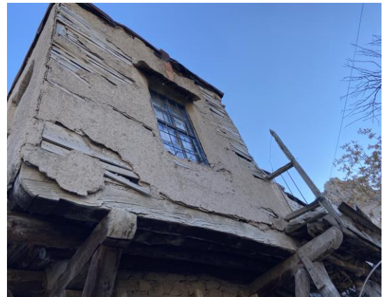
Şekil 2. Sille’de geleneksel bir konut yapısında duvarda bağdadi uygulaması
