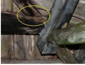
Resim 43. Kanallı geçme (ara aşıklar)
