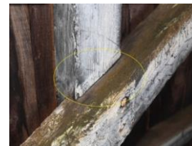
Resim 41-42. Kanallı geçmeler. Ana kiriş-yastık kirişi (41) (payanda-korkuluk kuşağı birleşimi (42).
