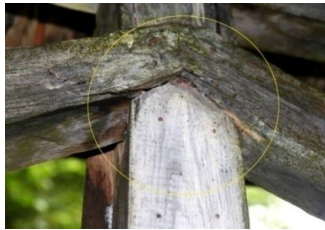
Resim 37-39. Kertmeli uç birleştirmeler. Payanda ve çatı kirişi (37), direk-payanda birleşimi (38), direk ve çatı kirişi ayrıntısı (39).
