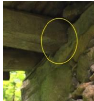
Resim 41-42. Kanallı geçmeler. Ana kiriş-yastık kirişi (41) (payanda-korkuluk kuşağı birleşimi (42).
