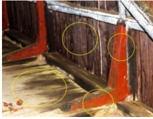
Resim 34-35. Köprüde görülen düz en birleştirmeler korkuluk iç yüzü (34), Padavra tahtaları (35).
