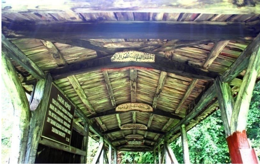
Resim 30. Çatı içten (kuzeydoğudan).
