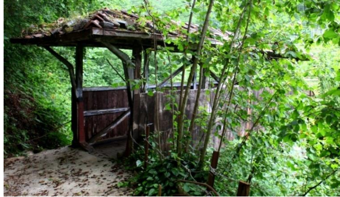
Resim 22. Güneybatı girişine mansab tarafından bakış.
