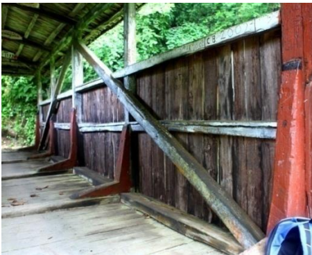
Resim 26. Tabliye korkuluğu içten (menba tarafı).
