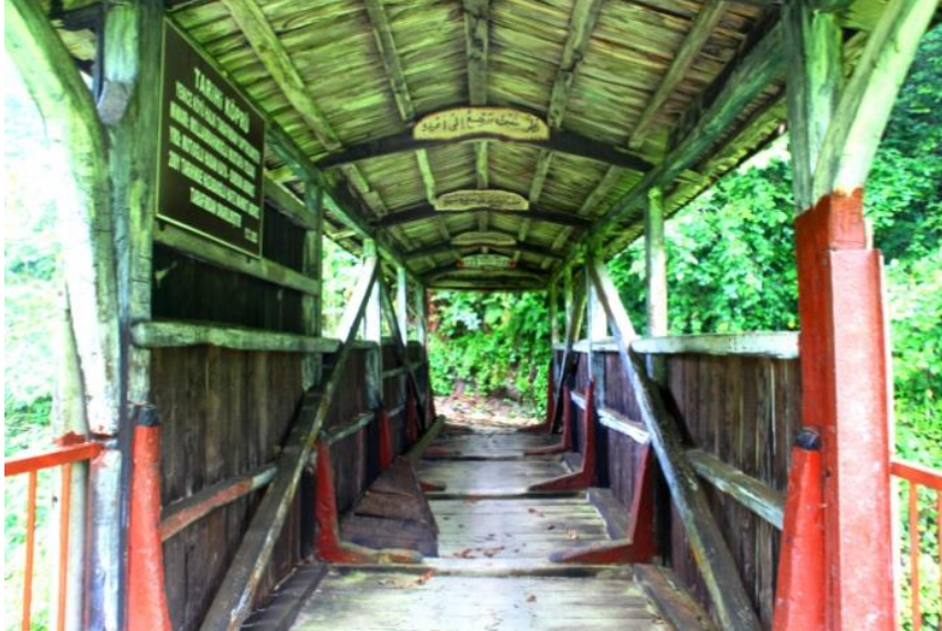
Resim 25. Köprü tabliyesi (kuzeydoğudan).
