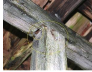
Resim 44. Zıvanalı geçme (direk çatı kirişi ayrıntısı).
