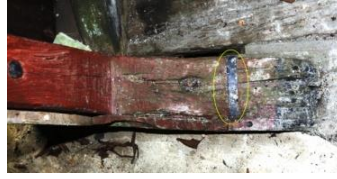
Resim 32. Tabliyede L payanda ayrıntısı.
