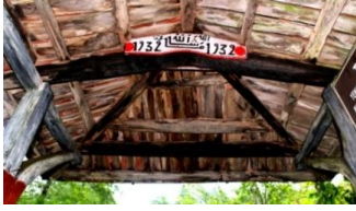
Resim 31. Çatı detayı (güneybatı uç kesim).
