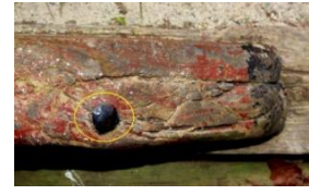
Resim 33. Tabliyede L payanda ayrıntısı.
