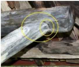
Resim 37-39. Kertmeli uç birleştirmeler. Payanda ve çatı kirişi (37), direk-payanda birleşimi (38), direk ve çatı kirişi ayrıntısı (39).
