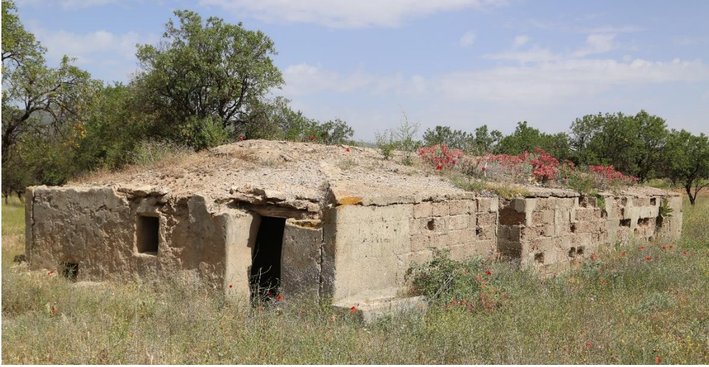
Fig.8 Hasan Hüseyin Sarıncı, Güneydoğudan.
