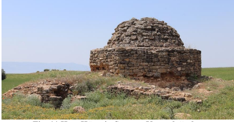
Fig. 11 Hacı Hüseyin Sarnıcı, Kuzeydoğudan.
