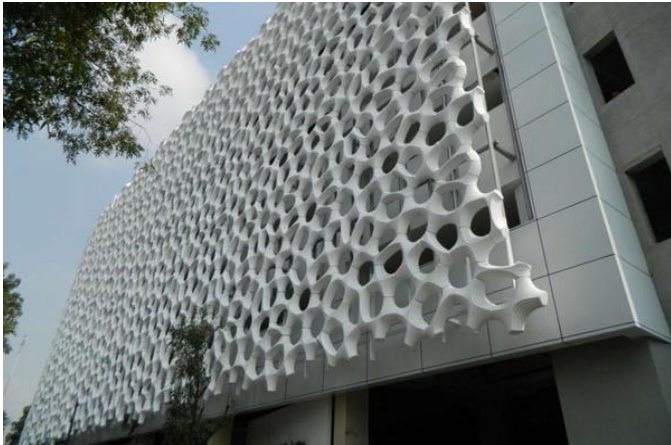
Şekil-7. Manuel Gea Gonzalez Hastanesi Cephesi (URL-7).
