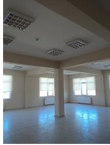
b) Bina iç görünüşü
