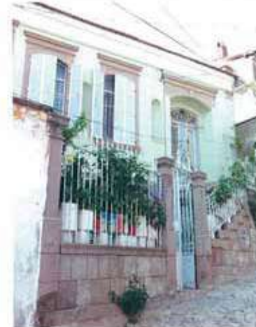
Res. 17. Aynı evin dış cephesi.
