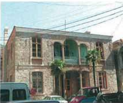
Res. 23. Eski Belediye binası (env. no: J18.B5.1494).
