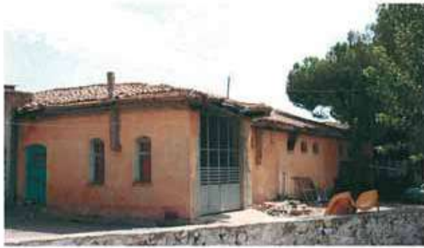
Res.30. Eski hâl binası (env. no: J18.B5.1658).
