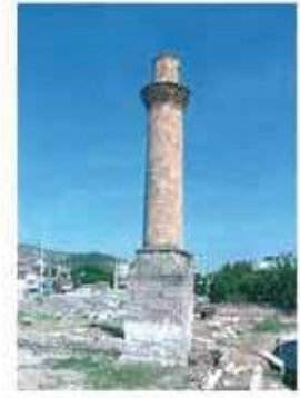
Res. 37. Emirsultan Minaresi (env. no: J18.B5.1226).
