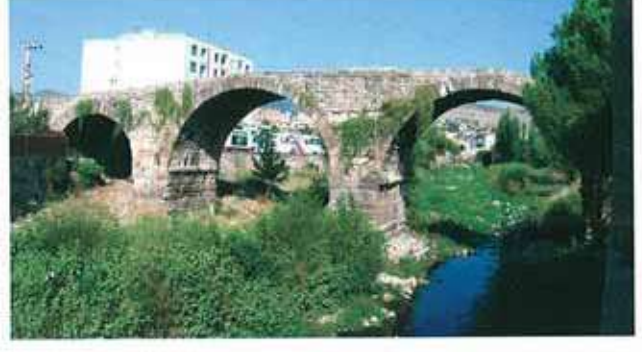
Res. 43. Üç Kemer Köprüsü (env. no: J18.B5.1120).
