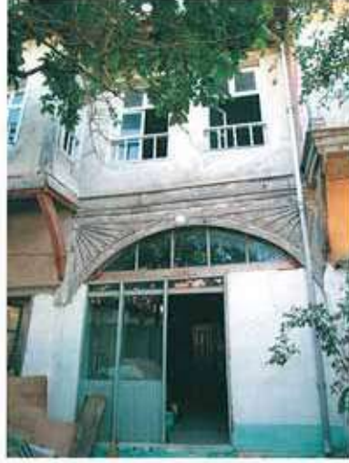
Res. 7. Dış cephesi.
