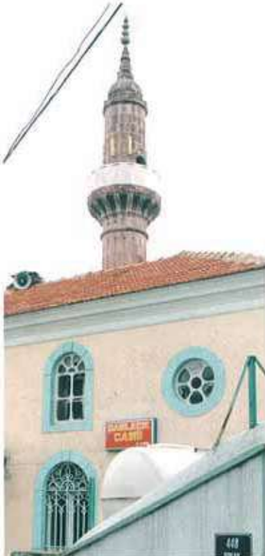
Res. 31. Damıacık Camii, 109 ada, 5 parselde (426. Sokak no. 21) bulunmaktadır.
