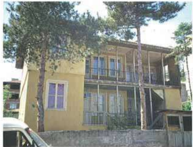
Res. 23. Arpacılar (Cemile Okumuş) evi (env. no: L29B0542), Tabiat Sokak.
