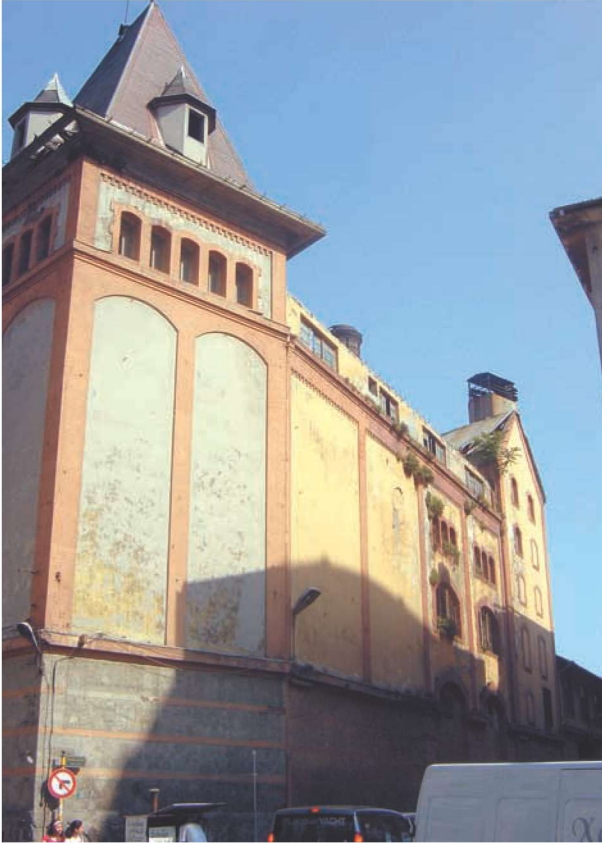
Res.9- C blok yapısı genel görünüm
