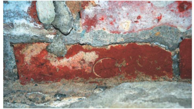
Res.12- Bomonti Bira Fabrikası'ndaki yığma yapılarda kullanılan Osmanlıca damgalı tuğlalardan bir örnek
