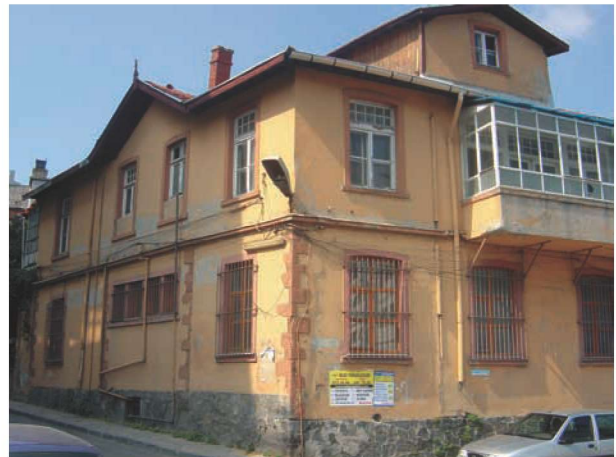
Res.7- A blok yapısı genel görünüm
