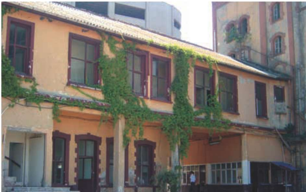
Res.8- B blok yapısı genel görünüm
