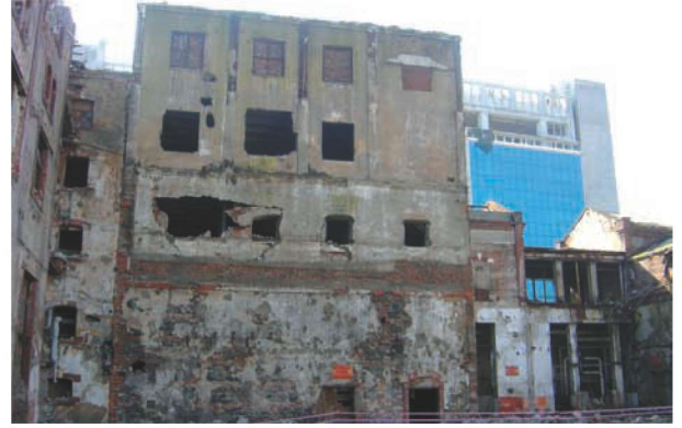
Res.10- D blok yapısı genel görünüm
