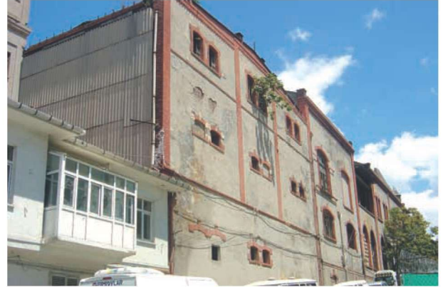
Res.11a- F blok yapısı genel görünüm
