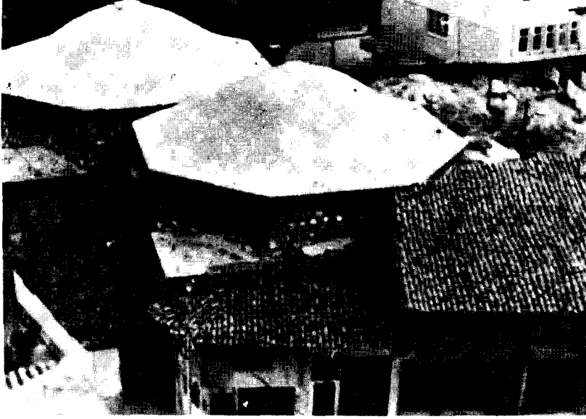
Resim : 9. Taceddin İbrahim Paşa Hamamı genel görünüş
