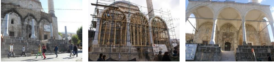
Resim 15. a. Son cemaat yeri sütunlarının montajı, b. Kemer ve kubbelerin kalıbı, c. Uygulama sonrası (Sevgi, 2008,2012)
