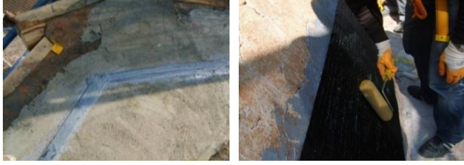
Resim 14. a. Kubbe eteğine karbon şerit, b. Kubbede karbon lif takviyeli polimer kumaş uygulaması (Sevgi, 2008)
