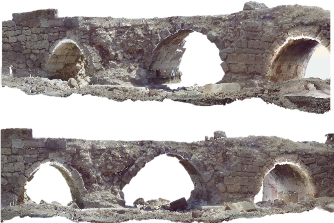
Şekil 4. Köprü'nün alt kısımlarının detaylı 3B nokta bulutu.
