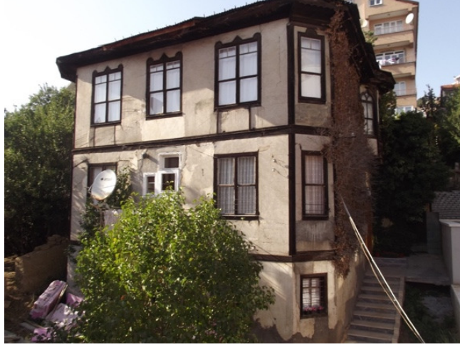
Resim 5. Saraç Emin'in Evi Cephe Düzenlemesi (Kişisel Arşiv- 17.09.2017)
