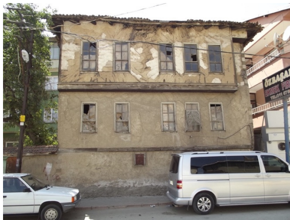
Resim 3. Bağdadi Tekniği Örneği (Konut şu an mevcut değildir-Kişisel Arşiv- 28.07.2013)
