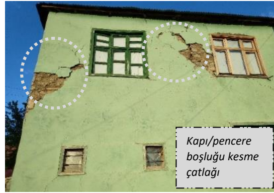
Şekil 12. Kapı Pencere Çevresinde Oluşan Hasarlar
