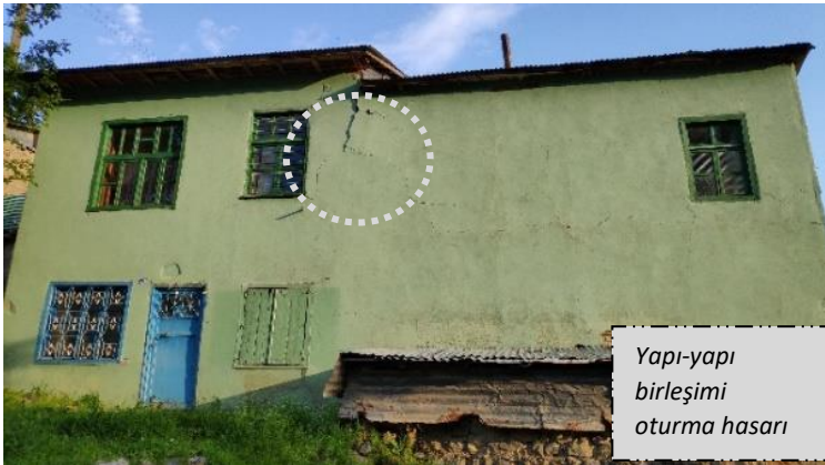
Şekil 13. Farklı Zemin Oturmalarına Bağlı Hasarlar
