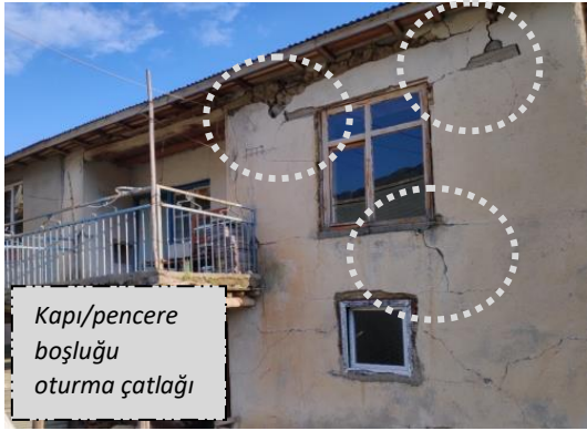
Şekil 12. Kapı Pencere Çevresinde Oluşan Hasarlar
