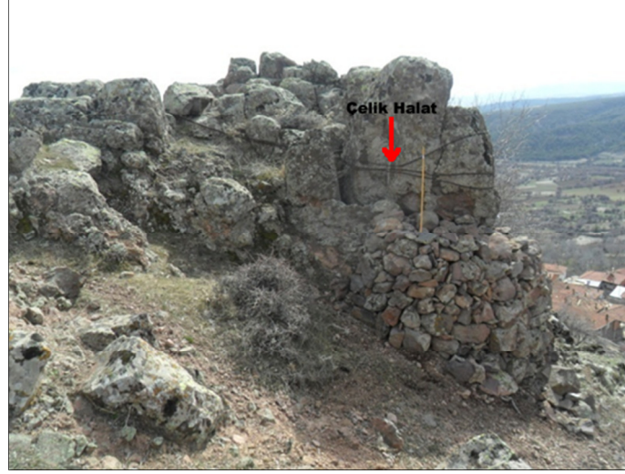
Foto 4: Düşme tehlikesi olan kayalar çelik halatlarla bağlanmış ve hareketini engellemek için taş duvarlarla sabitleştirilmeye çalışılmıştır.
