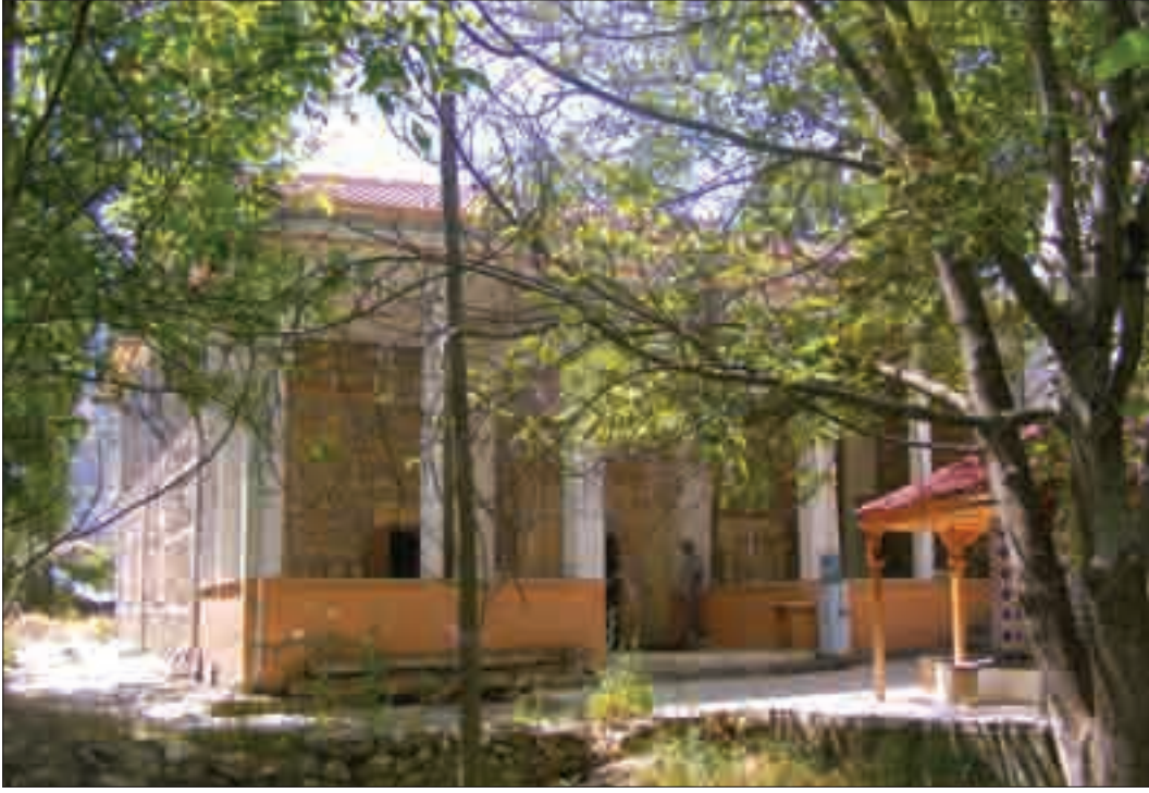
Resim 2: Bektaş Bey Camii'nin Kuzey Cephesi.
