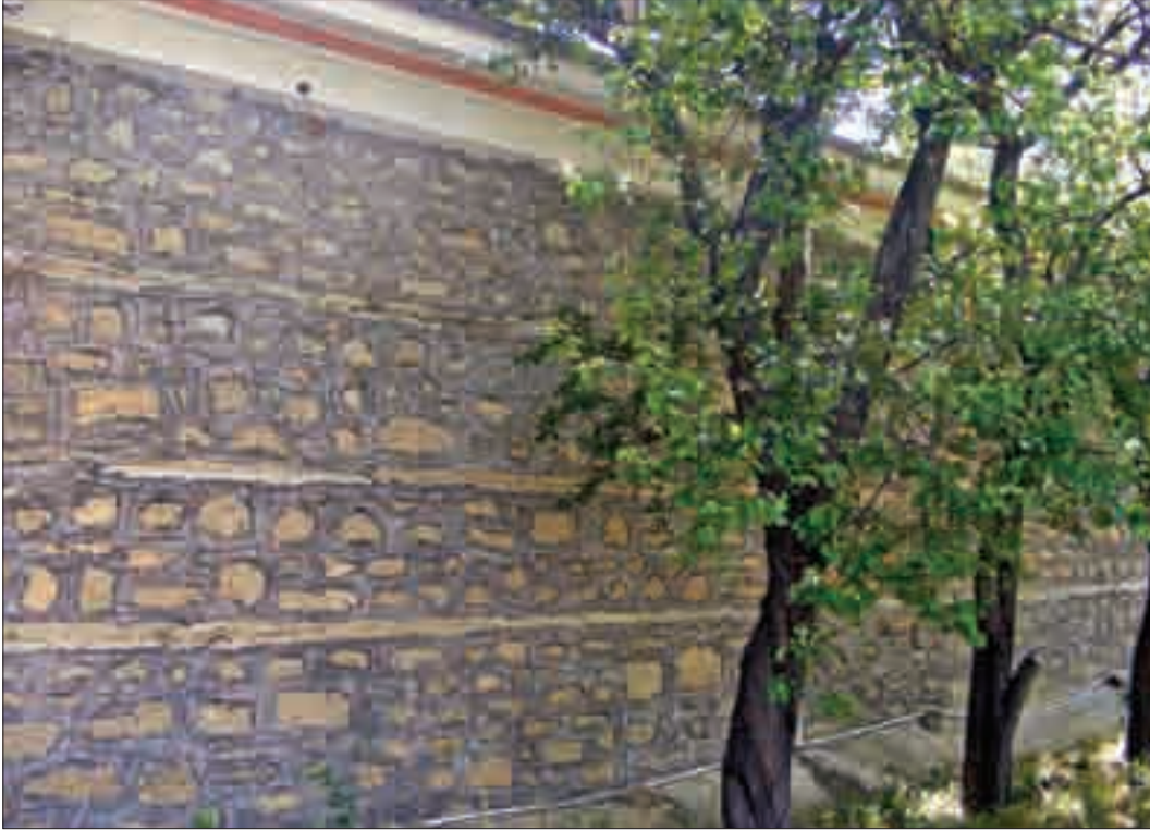
Resim 3: Bektaş Bey Camii'nin Batı Cephesi.
