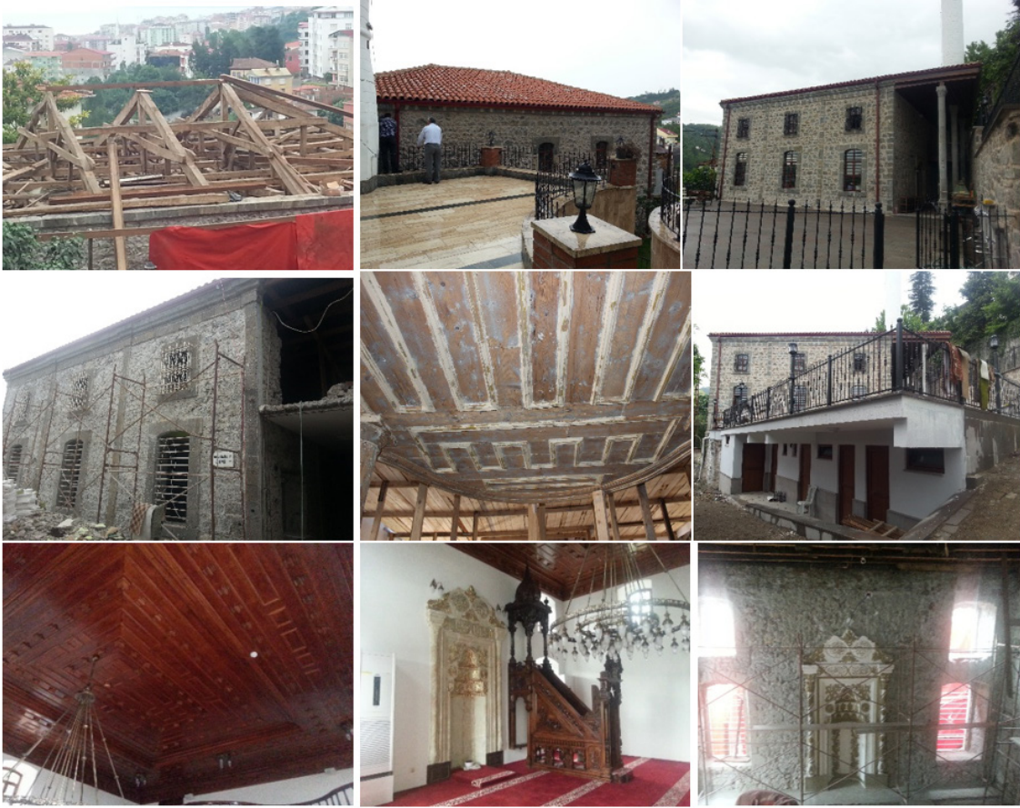
Resim 19. Orta Mahalle Camisi restorasyon süreci görselleri
