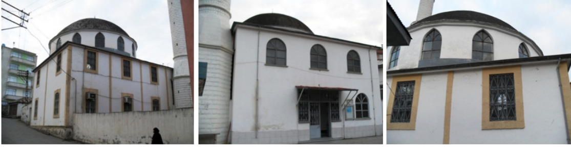
Resim 15. Dürbinar Camisinin restorasyon öncesine ait görüntüler
