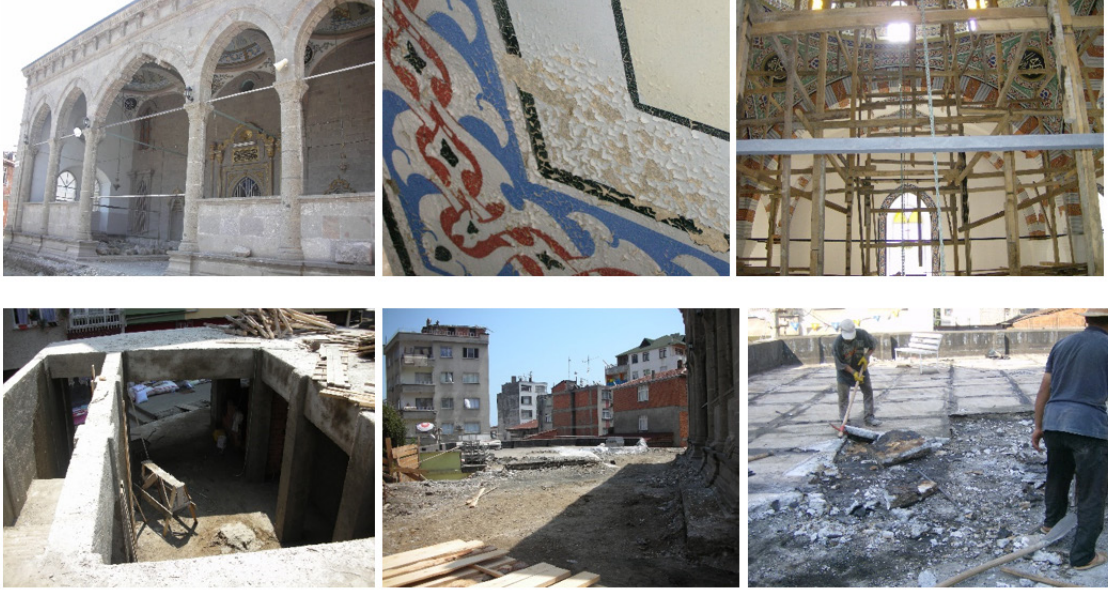
Resim 13. Yeni Cami Restorasyon Aşamasına Ait Fotoğraflar
