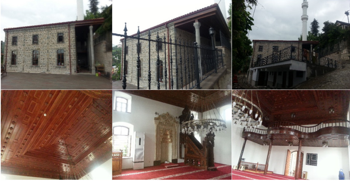
Resim 20. Orta Mahalle Camisi restorasyon sonrası görüntüleri
