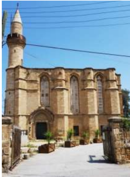
Şekil 8: St. Catherine Katedrali güney cephesi (Öztürk, 2018)
