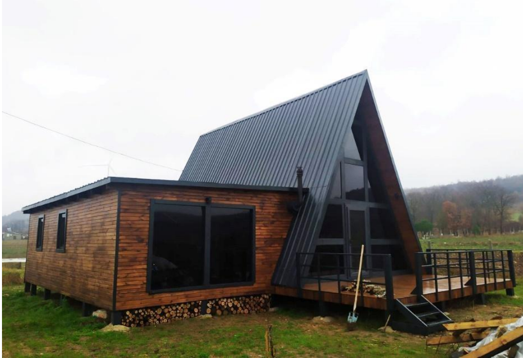
Şekil 10. Ek bölüm ve dış cephe (yazar arşivinden).
