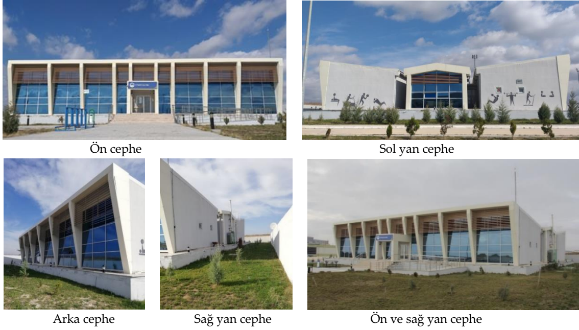
Şekil 9. Fitness Merkez Binasının cephe özellikleri, 2021
