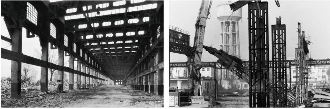
Resim 2: Eski Falck Çelik Fabrikası Tesisleri [1]
