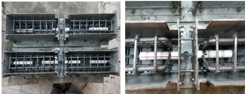
Şekil 18. Beton dökümüne hazır hale getirilmiş kalıp örneği
